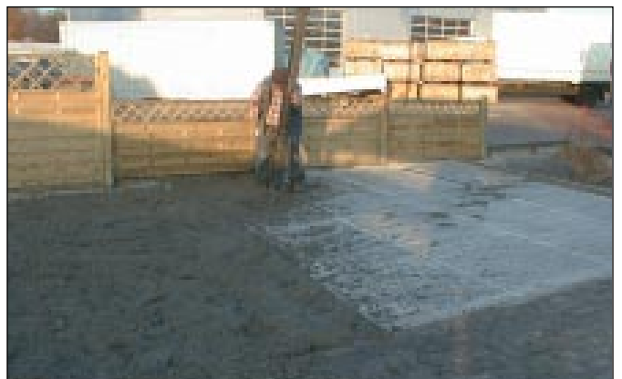
Bild 16: Aufbringung der Beton-Deck-Schicht
