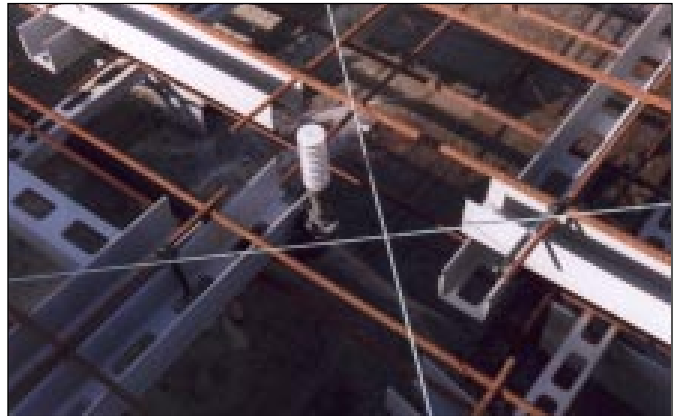
Bild 14: Einbau der Multiringelektrode
