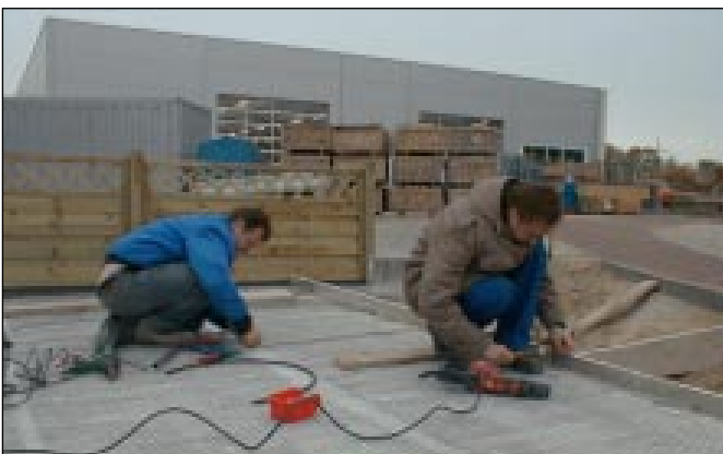
Bild 15: Montage der Titan-Anodenmatten
