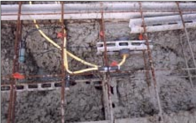
Bild 13: Typische Anordnung der Mess-Elektroden
