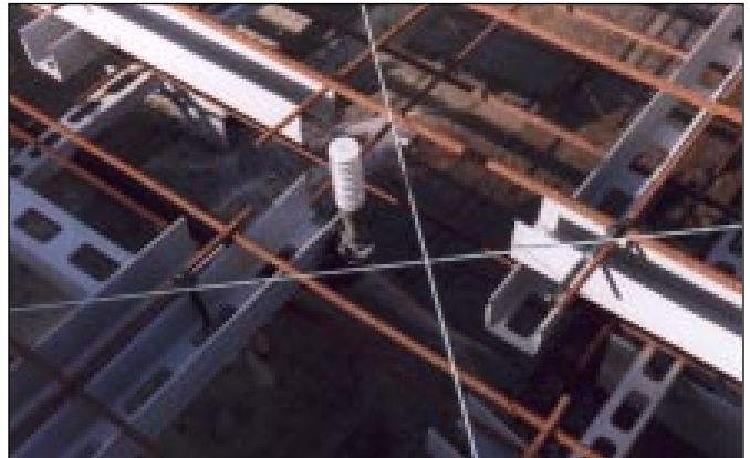
Bild 14: Einbau dere Multiringelektrode
