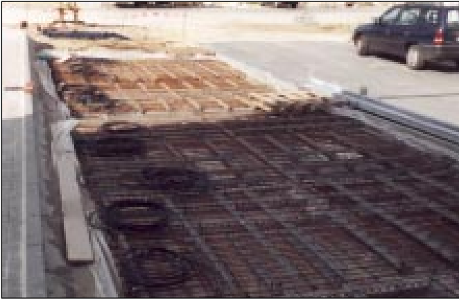
Bild 11: Bewehrungsstahl Anordnung
