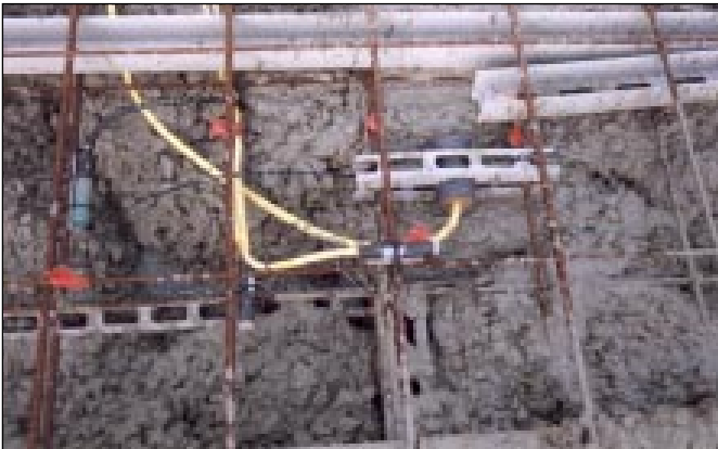
Bild 13: Typische Anordnung der Mess-Elektroden
