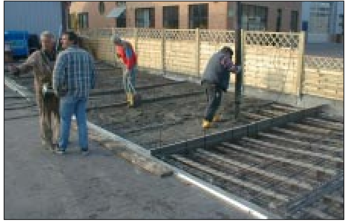
Bild 12: Betonierung der Plattform
