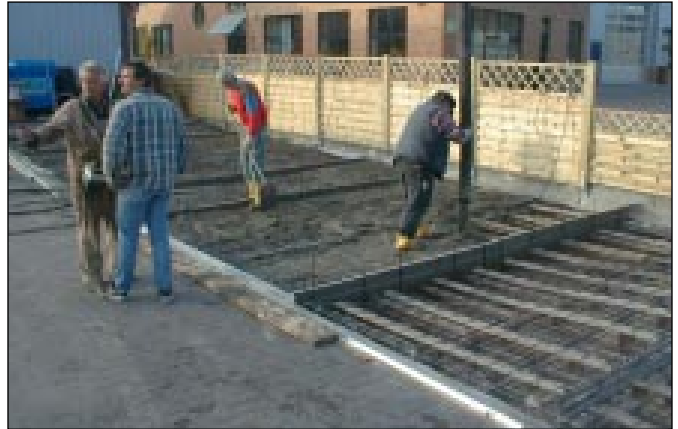
Bild 12: Betonierung der Plattform
