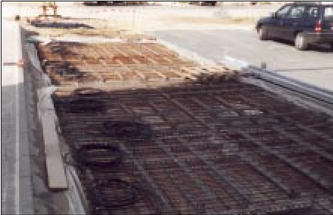
Bild 11: Bewehrungsstahl Anordnung
