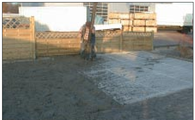
Bild 16: Aufbringung der Beton-Deck-Schicht
