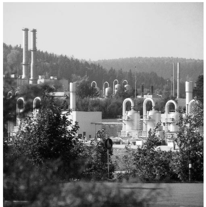
Bild 5: Der lokale kathodische Korrosionsschutz spielt vor allem in komplexen Industrie- und Versorgungsanlagen – zum Beispiel Verdichterstationen – eine Rolle.
